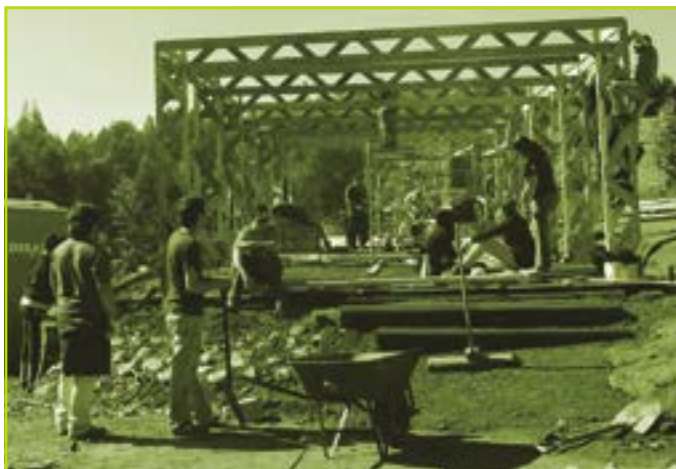
Fotografía 1. Proceso de construcción del comedor público
