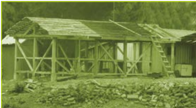
Fotografía 3. Imagen de la vivienda en proceso de construcción
