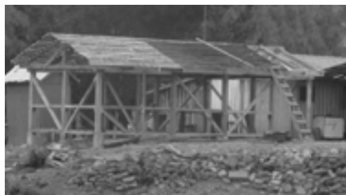
Fotografía 3: Imagen de la vivienda en proceso de construcción en la comunidad de Copiulemu
