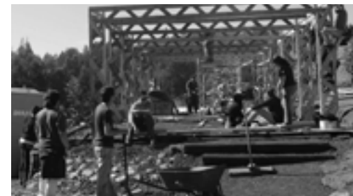
Fotografía 1: Proceso de construcción del comedor público
