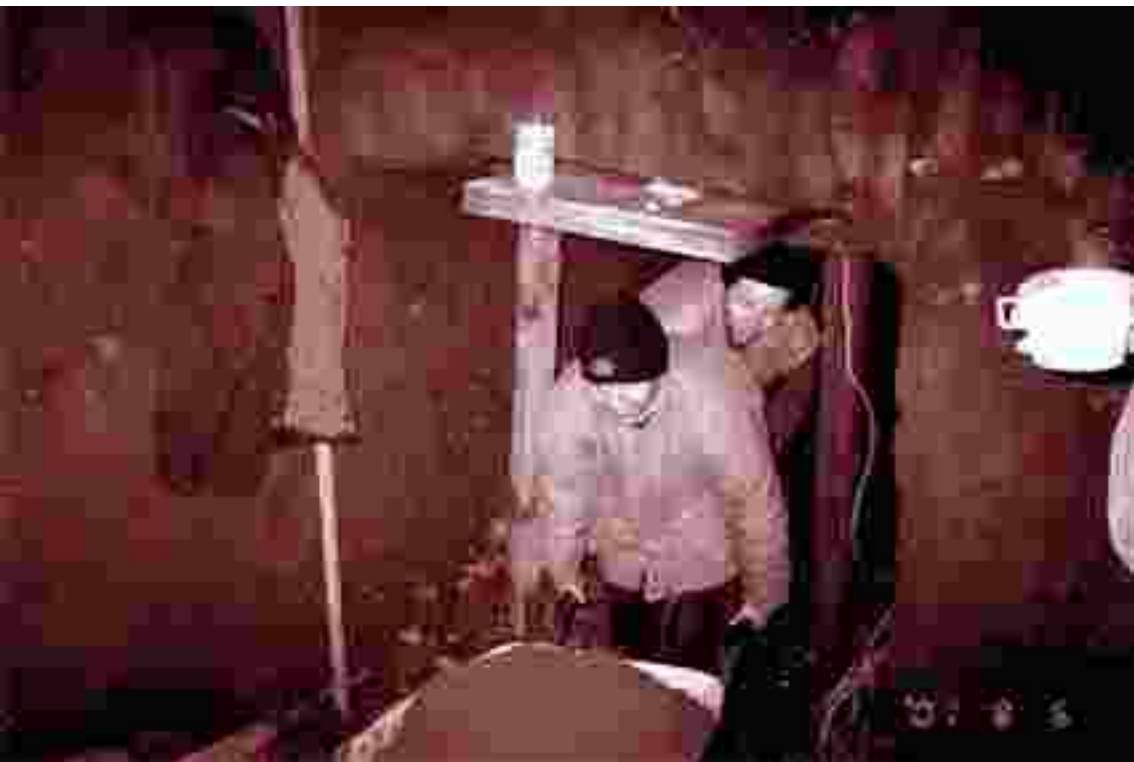
Túnel para armar la red de cañerías que suministrara agua a las casas de la toma (imagen facilitada por pobladora Carolina Sanhueza).
