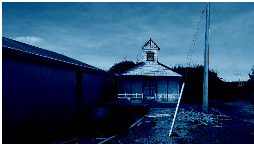
Fotografía 7: instalación de tendido eléctrico en isla Autení
