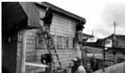
Fotografía 3. Maestros constructores y comunidad apoyando en recuperación de fachada.
