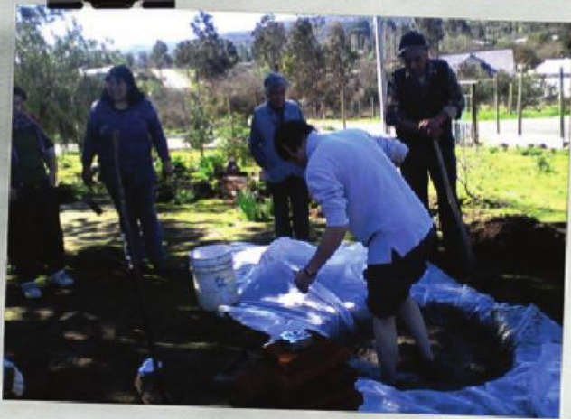
Construcción de hornos eficientes, septiembre 2011.
